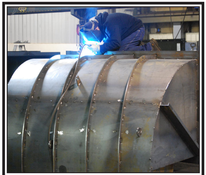
Actual Duct Fabrication in Progress
